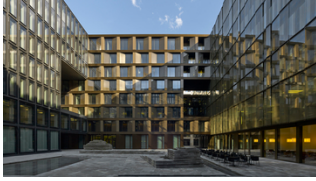
Europaallee 21, área de Construcción C, Zurich, CH
