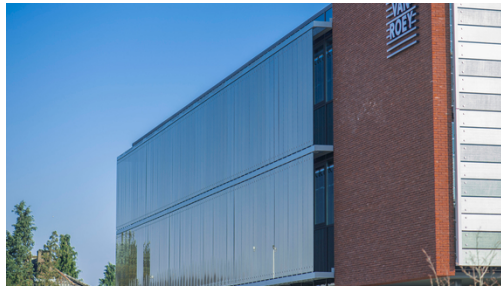
Construction company van Roey, Het Looi Rijkvorschel, BE
